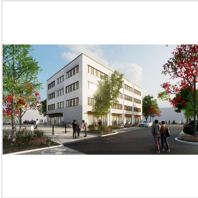
Gebäudeansicht aus Süd/Ost
